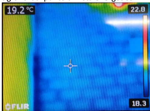
Figura 1.2 – Immagine termografica muro perimetrale
